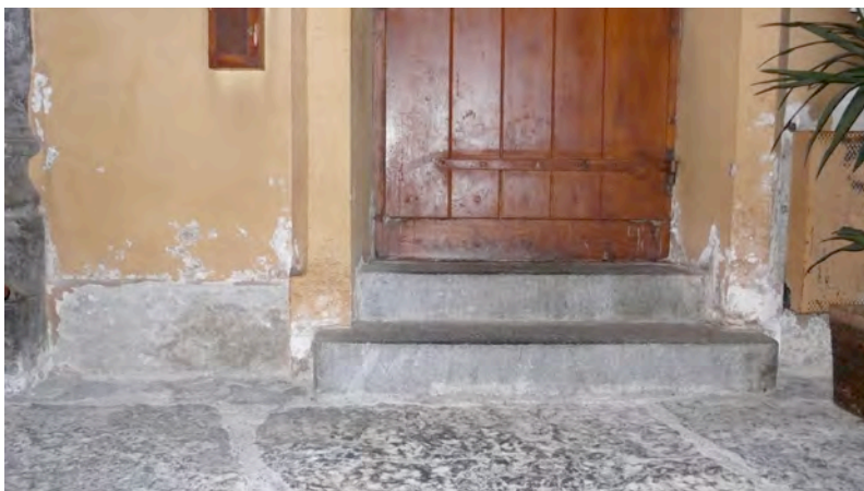
fig. 8 et 9: Remontées capillaires, Assainissement des bas de murs pour traiter les dégâts dus aux remontées capillaires
