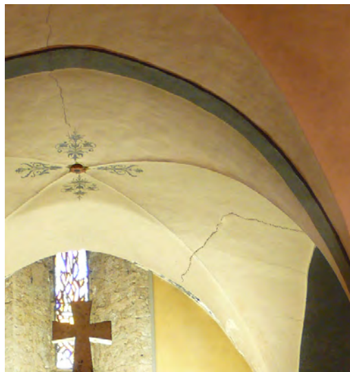
fig. 1 et 2: Colmatage des fissures afin de prévenir le détachement de parties d'enduit ou de crépi.
