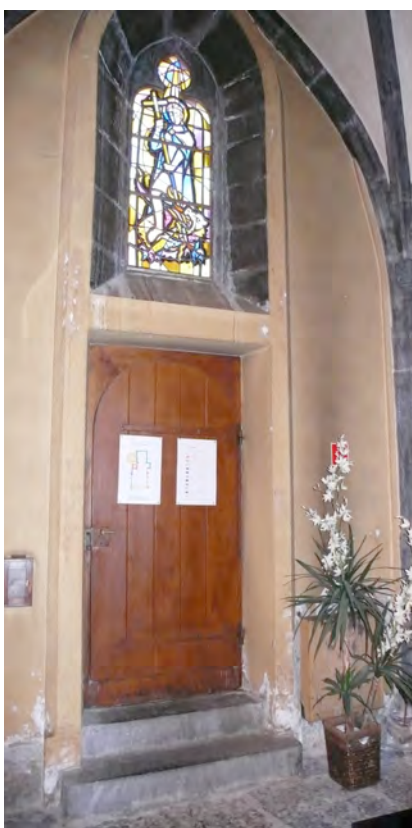
fig. 47: Lors de la reconstruction de 1933, les pierres de l'ancienne baie ont été replacées dans un mur moins épais qu'à l'origine. Un façon d'encadrement de ciment rattrape le décalge d'épaisseur.
