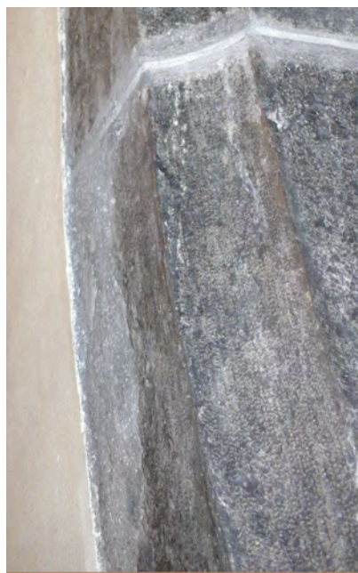
fig. 10 et 11: Autrefois les enduits se fondaient au même niveau que les queues des pierres de taille et les décors peints régularisaient le dessin des encadrements. Ici, dans le chœur, le crépi ciment est en surépaisseur par rapport aux encadrements de pierre et la régularisation est faite avec du mortier teint. Il semble que des décors peints subsistent partiellement, des recherches et le projet de conservation-restauration détermineront l'attitude à adopter.
