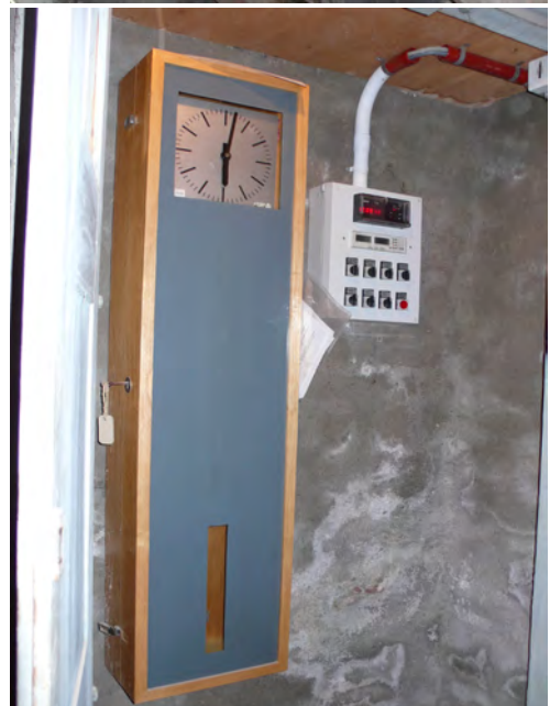
fig. 15: Côte-à-côte, deux générations d'horloge de commande de sonnerie des heures. Les deux ne fonctionnent plus. Le tableau de commande de la mise en volée est dans le local technique sous le beffroi.
