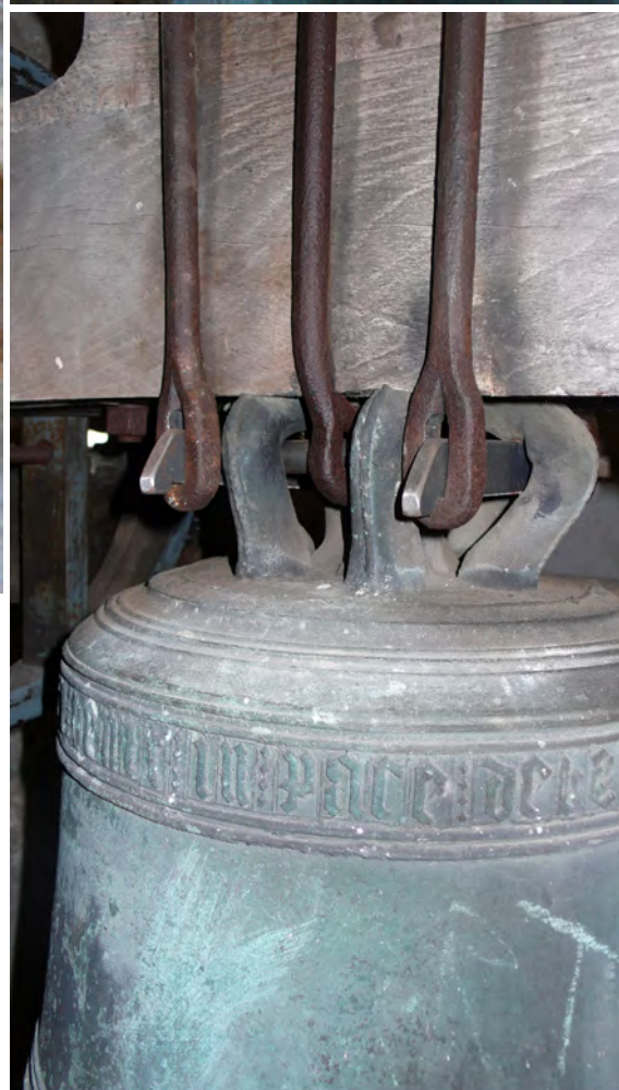
fig. 77, 78 et 79: La cloche gothique, fin XVe-début XVIe, ø60cm. Les ferrures verticales ont été entretenues, les rondelles et la cales ajustées, les pas de vis et les écrous graissés pour assurer la cohérence de l'assemblage. Les pas de vis n'ont pas été modifiés. Les traverses qui passent à travers les anses étaient tordues car trop minces et serrées trop forts, elles ont été remplacées.
