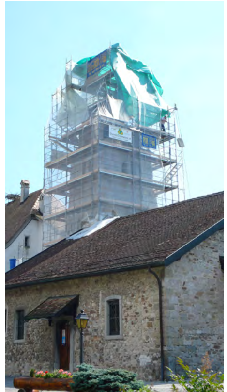
fig. 17: Echafaudages, protections contre les chutes d'objet, le soleil et la pluie.
