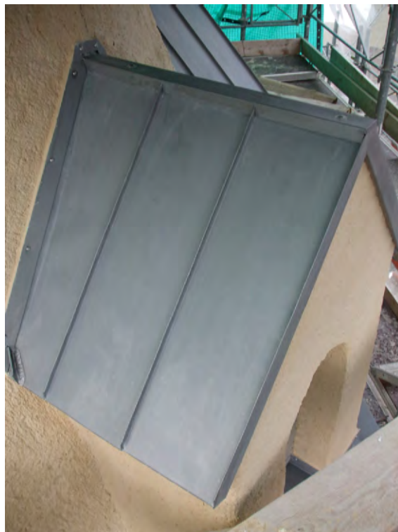
fig. 23: Couvertures des lucarnes réalisées en placage inox prépatiné teinte zinc.
