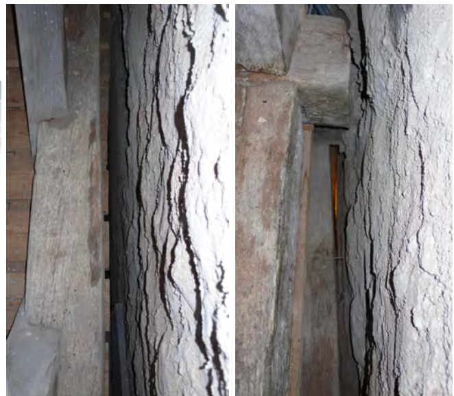
fig. 37: Le piquage du crépi ciment et une recharge minimum avec un dégrossissage à la chaux au droit des pièces de charpente a permis de garantir le passage de l'air entre les pièces en bois et la maçonnerie.
