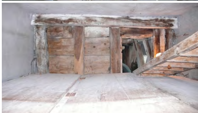
fig. 9: La paroi du local technique, le plancher support du beffroi sont opaques et bloquent la circulation d'air. A droite l'échelle d'accès à la base du beffroi.
