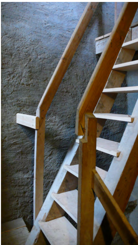
fig. 56 et 57: Les marches dont les nez étaient trop endommagés ont été remplacées et les mains courantes renforcées.
