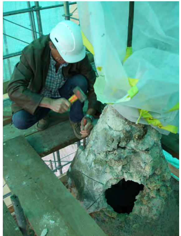
fig. 19: Piquage délicat du crépi ciment très dur sur le tuf mince affaibli par l'humidité.
