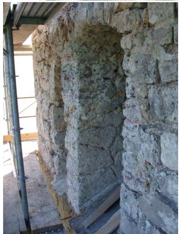
fig. 17: Echafaudages, protections contre les chutes d'objet, le soleil et la pluie.
