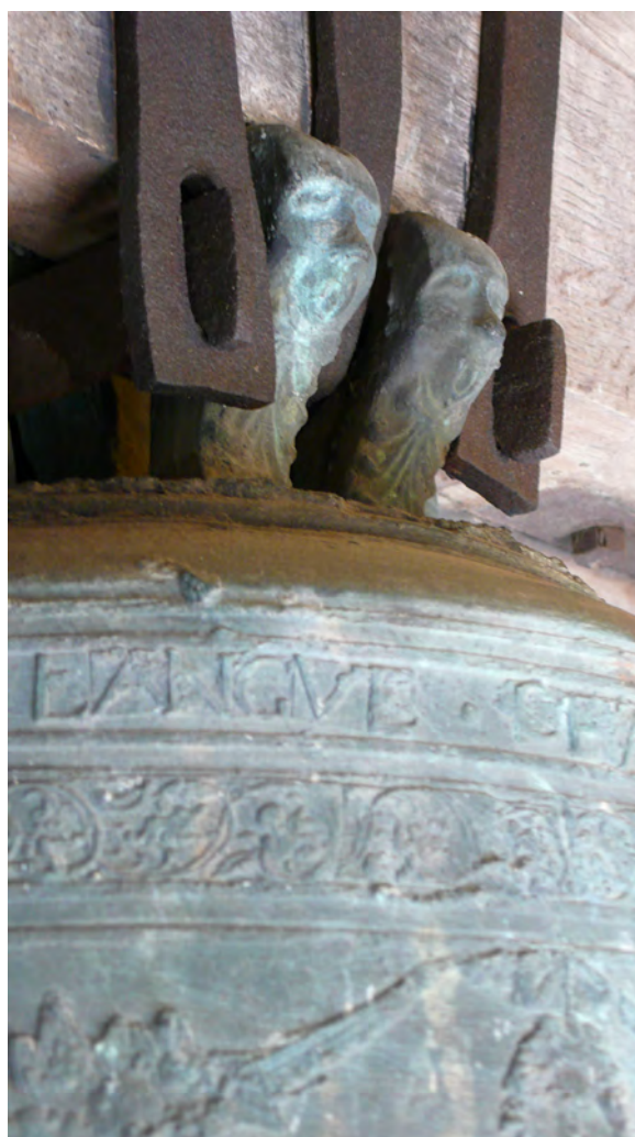
fig. 71, 72 et 73: La cloche de Midi, 1679, ø80cm. Les ferrures verticales ont été entretenues, les rondelles et la cales ajustées, les pas de vis et les écrous graissés pour assurer la cohérence de l'assemblage. Les pas de vis n'ont pas été modifiés.
