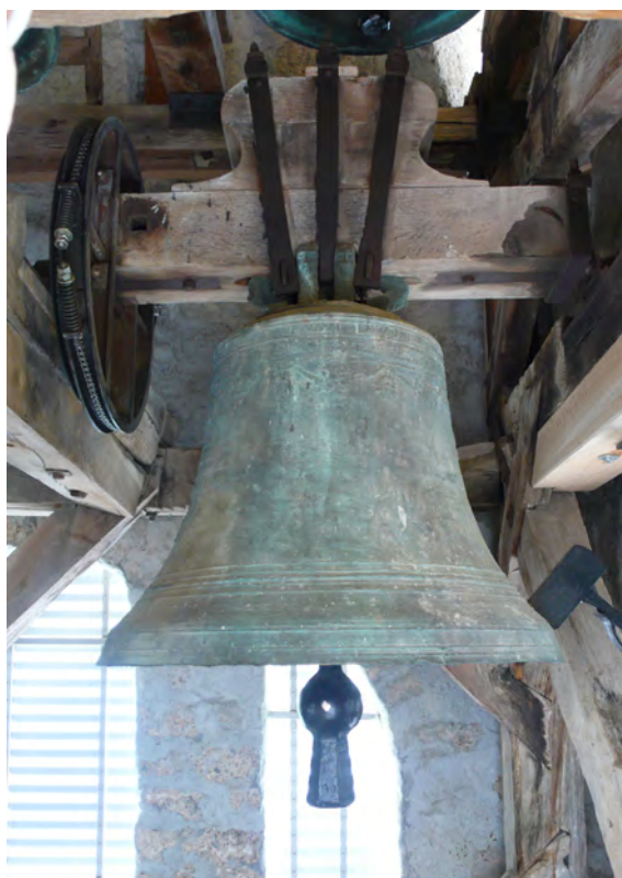
fig. 71, 72 et 73: La cloche de Midi, 1679, ø80cm. Les ferrures verticales ont été entretenues, les rondelles et la cales ajustées, les pas de vis et les écrous graissés pour assurer la cohérence de l'assemblage. Les pas de vis n'ont pas été modifiés.
