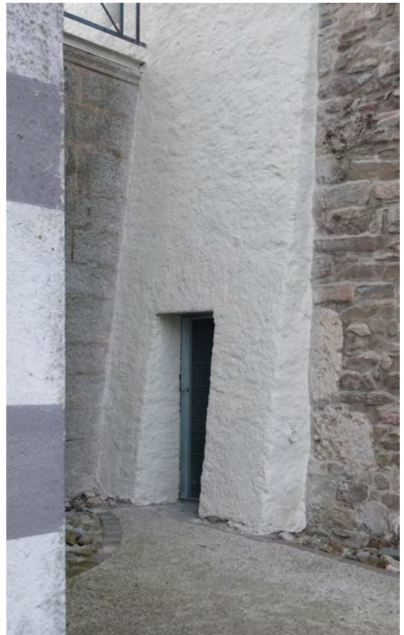
fig. 61 et 62: La porte opaque en bois a été remplacée par une porte en caillebotis afin d'optimiser l'aération naturelle du clocher pour favoriser son assèchement rapide après la pluie.
