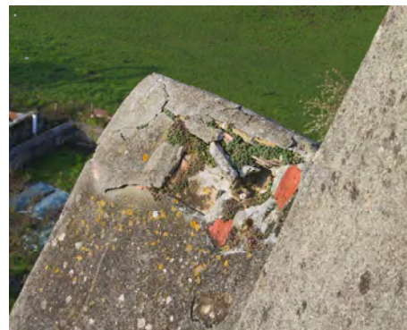
fig. 5: Couverture à la base de la flèche éventrée
