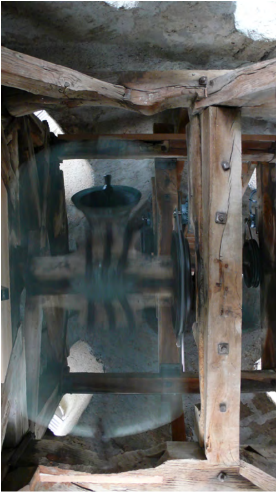
fig. 80 et 81: Essais de mise en volée des trois cloches simultanément et observation des oscillations de la charpente du beffroi. Définition des derniers calages des assemblages du beffroi et réglages des courses des mises en volée.
