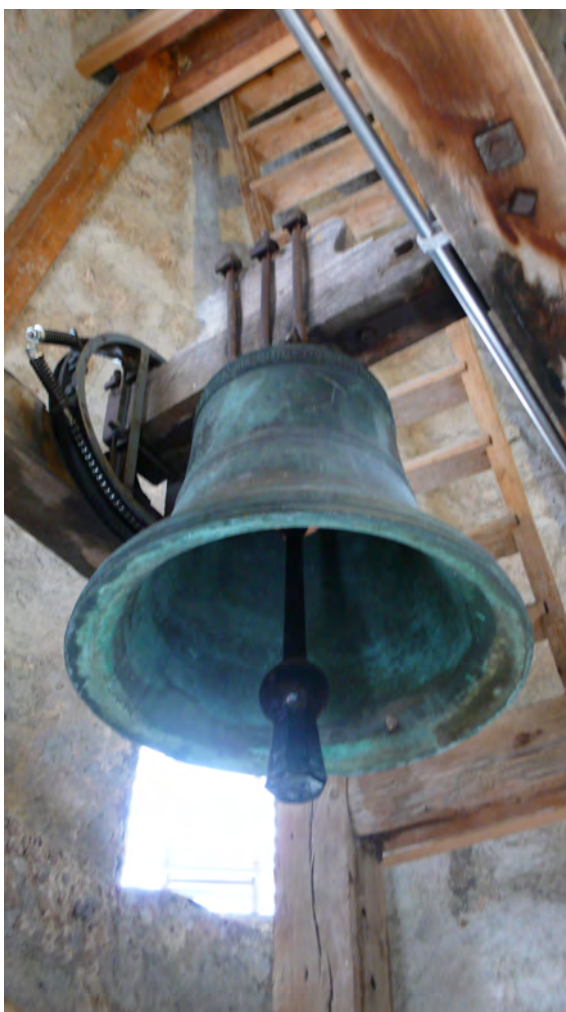
fig. 77, 78 et 79: La cloche gothique, fin XVe-début XVIe, ø60cm. Les ferrures verticales ont été entretenues, les rondelles et la cales ajustées, les pas de vis et les écrous graissés pour assurer la cohérence de l'assemblage. Les pas de vis n'ont pas été modifiés. Les traverses qui passent à travers les anses étaient tordues car trop minces et serrées trop forts, elles ont été remplacées.
