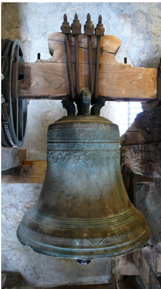
fig. 74, 75 et 76: La cloche de l'Ecole, 1672, ø63cm. Les ferrures verticales ont été entretenues, les rondelles et la cales ajustées, les pas de vis et les écrous graissés pour assurer la cohérence de l'assemblage. Les pas de vis n'ont pas été modifiés.
