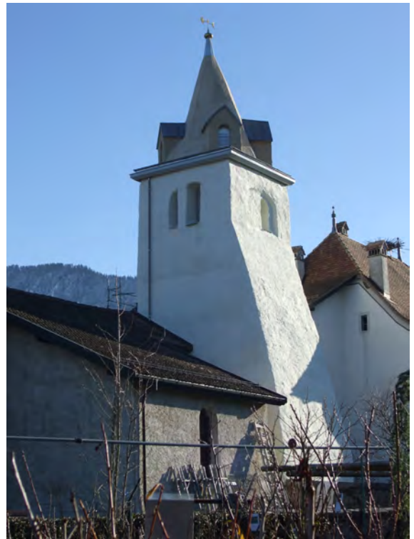
fig. 26: Le crépi mis en place est à base de chaux hydratée et de chaux hydraulique, il a été enduit à la chaux, une teinte plus foncée a été donnée à la flèche afin que sa maçonnerie s'échauffe plus vite au soleil et favorise ainsi un mouvement d'air ascendant dans le clocher pour accentuer l'aération naturelle et augmenter les possibilités d'assèchement.
