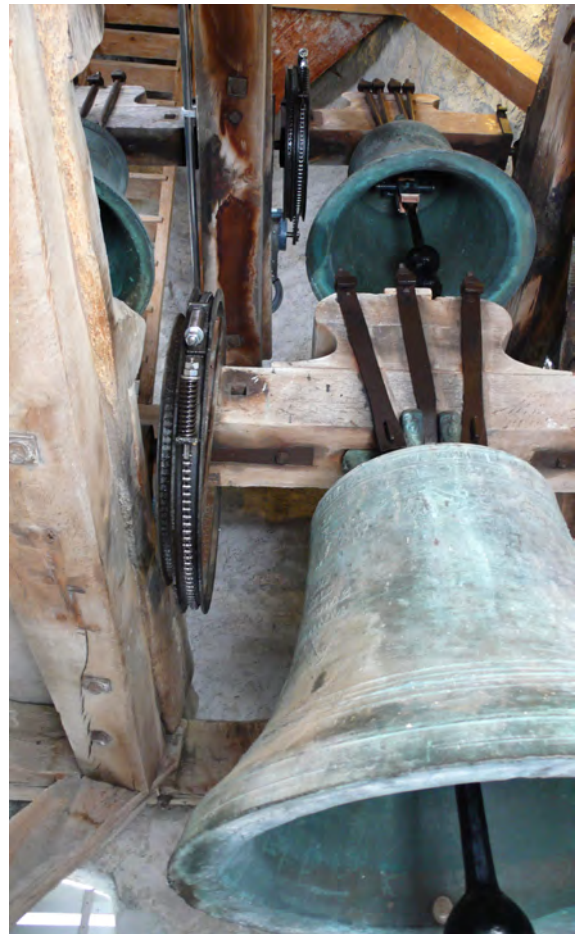
fig. 63: Vue des trois cloches dans le beffroi. En bas à droite, la cloche dite de Midi, 1679, ø80cm. En haut à droite, la cloche dite de l'Ecole, 1672, ø63cm. En haut à gauche, la cloche gothique, fin XVe-début XVIe, ø60cm.
