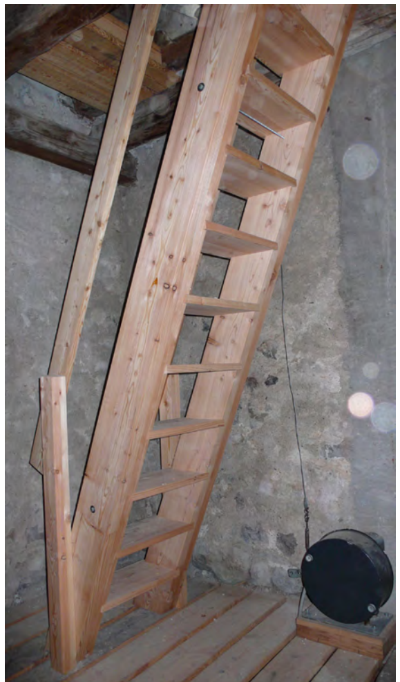
fig. 54: La nouvelle volée d'escalier qui relie le plancher de service à la base du beffroi. A droite, le moteur du marteau des heures qui a été réutilisé et remplacé à un endroit moins gênant qu'auparavant.
