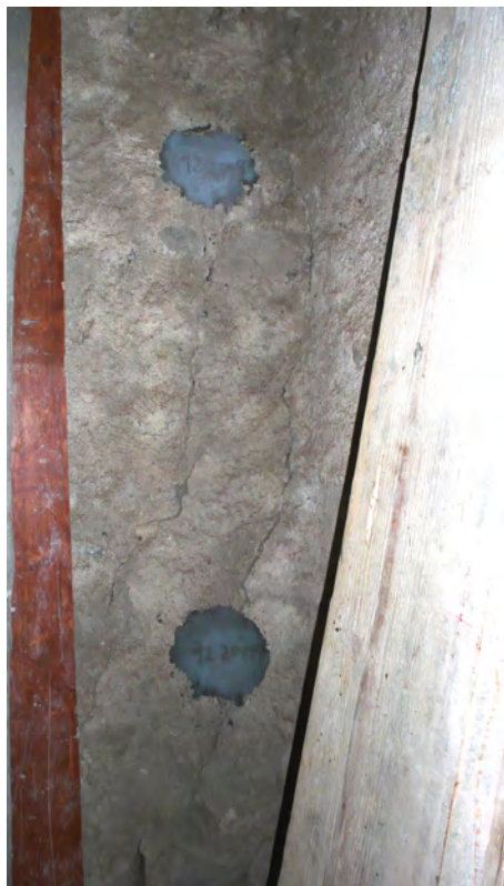
fig. 37: Le piquage du crépi ciment et une recharge minimum avec un dégrossissage à la chaux au droit des pièces de charpente a permis de garantir le passage de l'air entre les pièces en bois et la maçonnerie.
