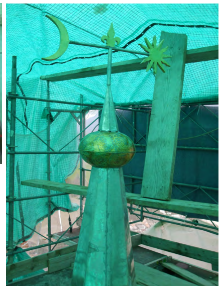
fig. 21: Epi de flèche neuf, qui chapeaute la maçonnerie de tuf afin de la protéger des pluies.
