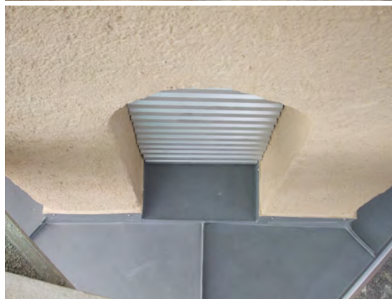
fig. 24: Couverture de la base de la flèche et des tablettes des fenêtres réalisées en placage inox prépatiné teinte zinc.
