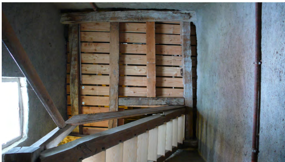
fig. 55: Vue du dessous du nouveau plancher de service à claire- voie réalisé également en mélèze non raboté.
