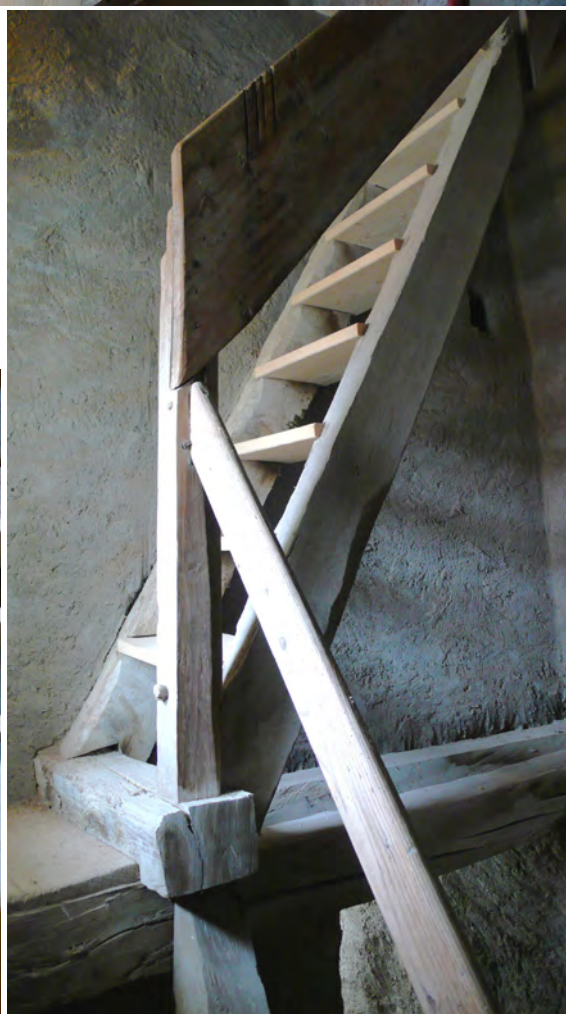
fig. 56 et 57: Les marches dont les nez étaient trop endommagés ont été remplacées et les mains courantes renforcées.
