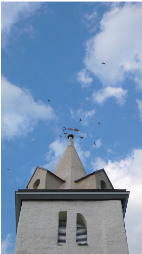
fig. 26: Le crépi mis en place est à base de chaux hydratée et de chaux hydraulique, il a été enduit à la chaux, une teinte plus foncée a été donnée à la flèche afin que sa maçonnerie s'échauffe plus vite au soleil et favorise ainsi un mouvement d'air ascendant dans le clocher pour accentuer l'aération naturelle et augmenter les possibilités d'assèchement.
